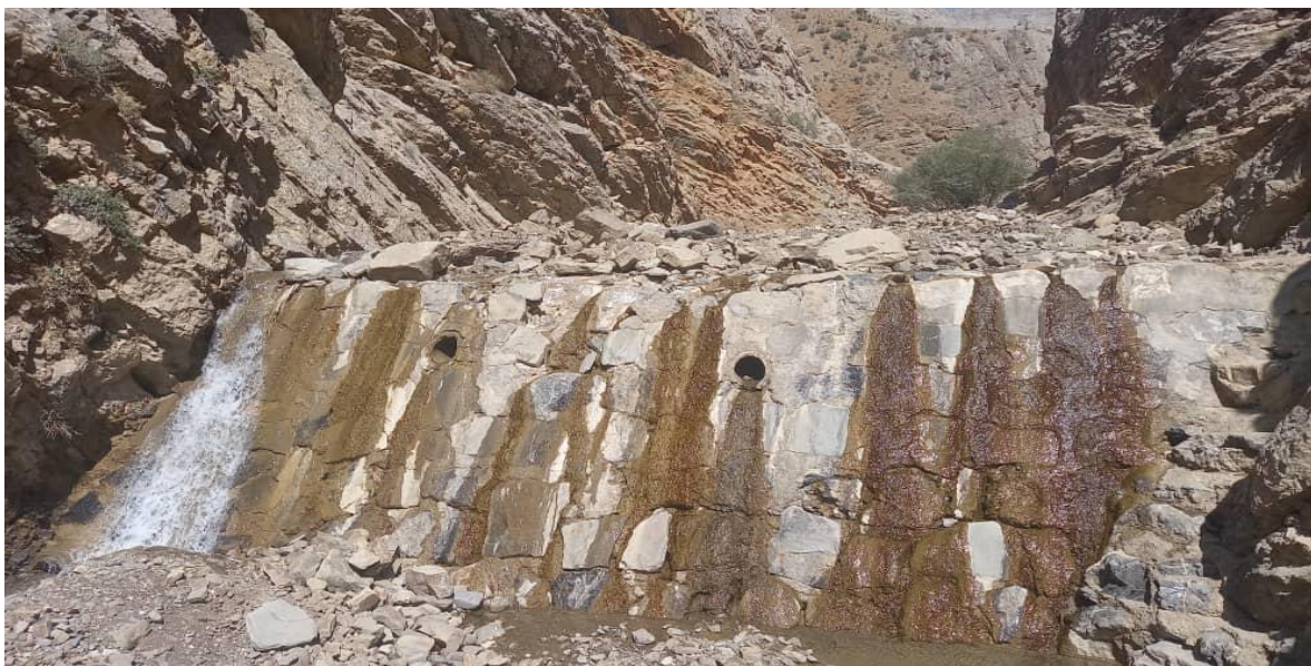
شکل ۶- سازه گابیونی و سنگی و ملاتی اساسی با کارایی مناسب در منطقه
